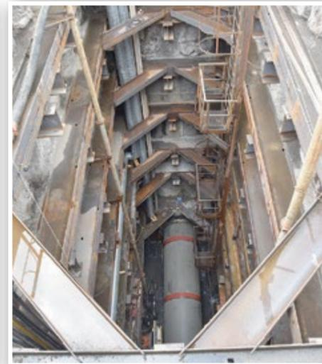
В рамках реконструкции газопровода-дюкера «Автозаводский» в районе Нагатинской набережной специалисты АО «МОСГАЗ» с опережением графика завершили строительство железобетонного тоннеля под дном Москвы-реки на глубине более 10 метров. «Автозаводский» — первый объект, предусмотренный масштабной программой реконструкции подводных газопроводов столицы.
