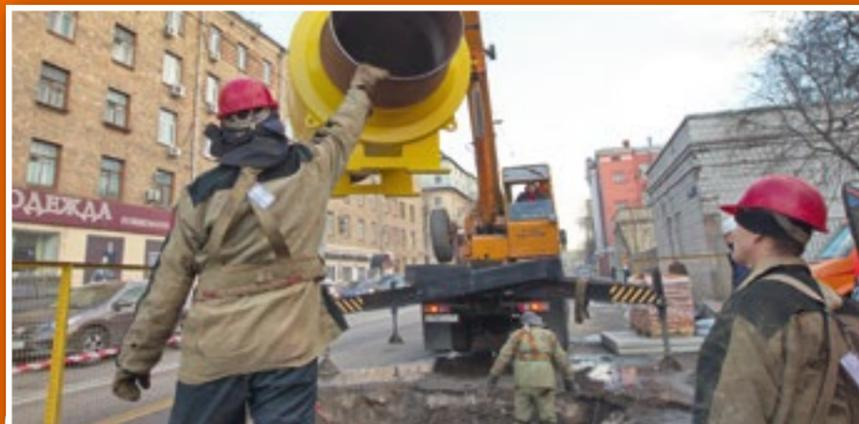
Сейчас в Москве заменено на газопроводах среднего и высокого давления 533 запорных устройства, из них более 300 оснащены электроприводом. Работы не прерываются и в зимнее время. Это достигается за счет использования современного оборудования и технологий, которые позволяют переключать участок газопровода без отключения потребителя. Ежегодно силами ОАО «МОСГАЗ» устанавливается не менее 75 автоматизированных запорных устройств.
