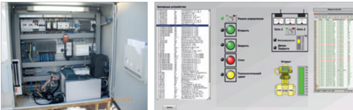
Автоматическая система дистанционного управления запорными устройствами
