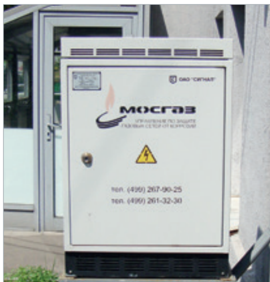
Станция катодной защиты с импульсным выпрямителем и дистанционным контролем
