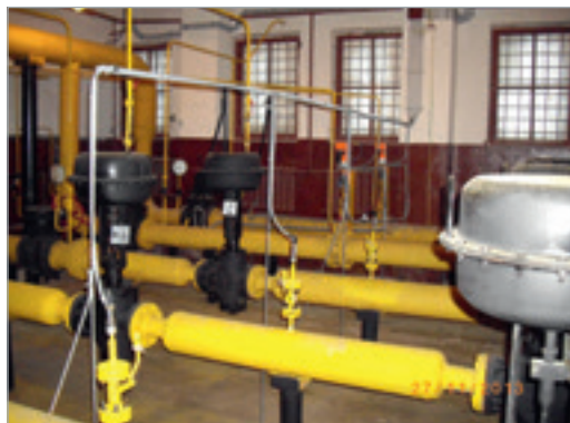
Автоматическая система измерения и контроля технологических параметров природного газа
