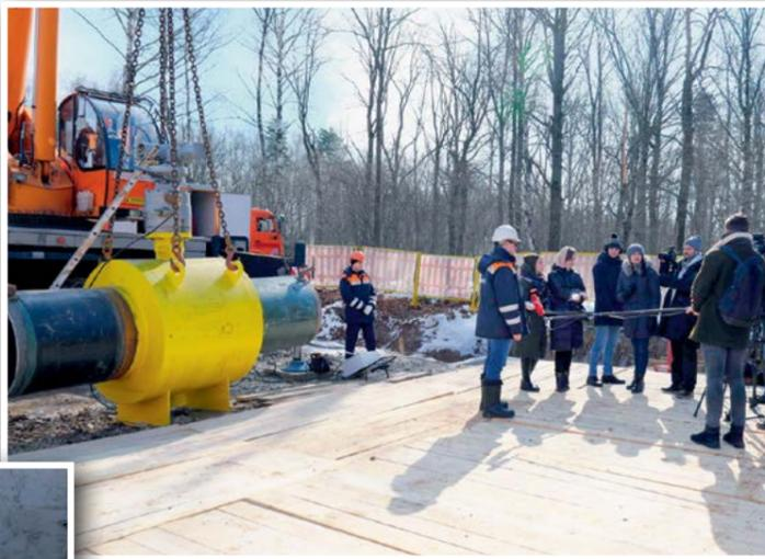
Запорные устройства обязательно устанавливаются в местах пересечения газопровода с дорожно-транспортными магистралями и водными преградами.
