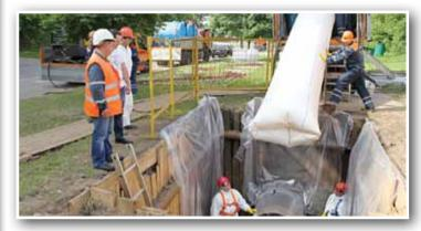
поверхности трубы. Более того, даже если газопровод потерял свою несущую способность, полимерный рукав внутри трубы способен в дальнейшем самостоятельно нести давление.
