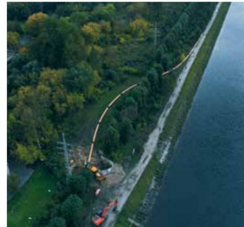
вый тоннель для дюкера протяженностью более 300 метров завершили в июле 2019 года. Затем по нему протянули герметичный защитный футляр диаметром 1200 мм, в котором установили стальную трубу газопровода диаметром 820 мм. Начало было положено.
